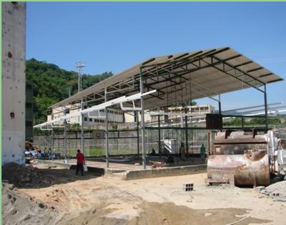
Acondicionamiento de Cancha Anexo de Máxima
